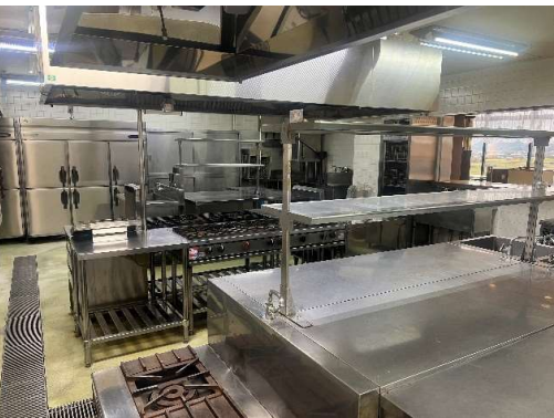
厨房スペース その1
