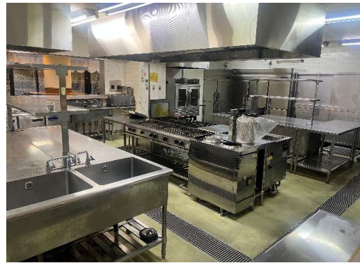
厨房スペース その2
